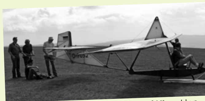
Ein Schulflugzeug Typ Schulgleiter SG 38, auf dem Vaters Schüler am Jaberg fliegen lernten. Die hier gezeigte Maschine fliegt heute noch auf der Wasserkuppe in der Rhön, dem Segelflieger-Mekka!
